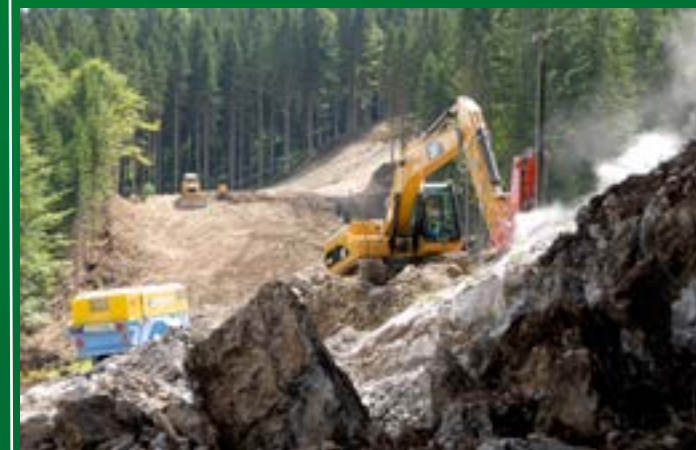
Erdarbeiten für die Ski-WM am Tröglhang
